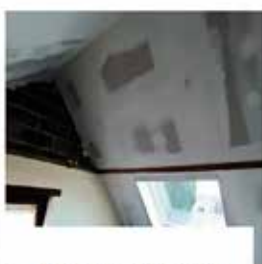
Finitions au dessus de l'isolation toiture
