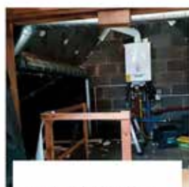
Pose de la chaudière au grenier
