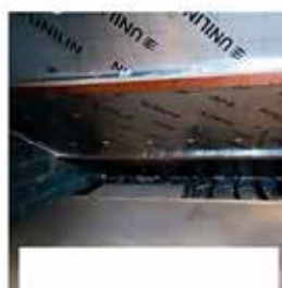
Isolation de la toiture
